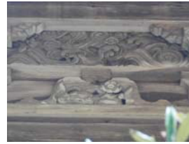
写真-17 鷹飛原八幡宮 中備2 矢地, 享保9(1725)
