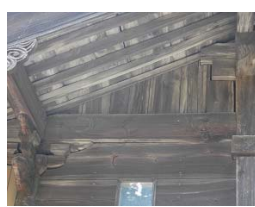
写真-37 松尾八幡宮 生野屋, 明和7(1770)
