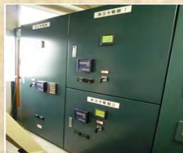
高圧配電盤更新
