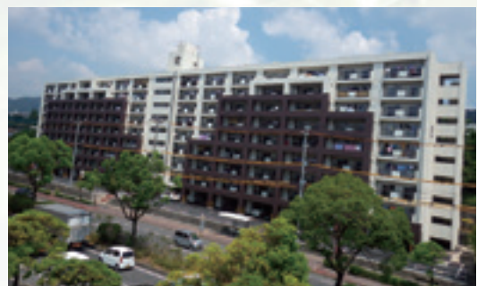
周南市 周南第3住宅12棟耐震補強改修工事（完成）
