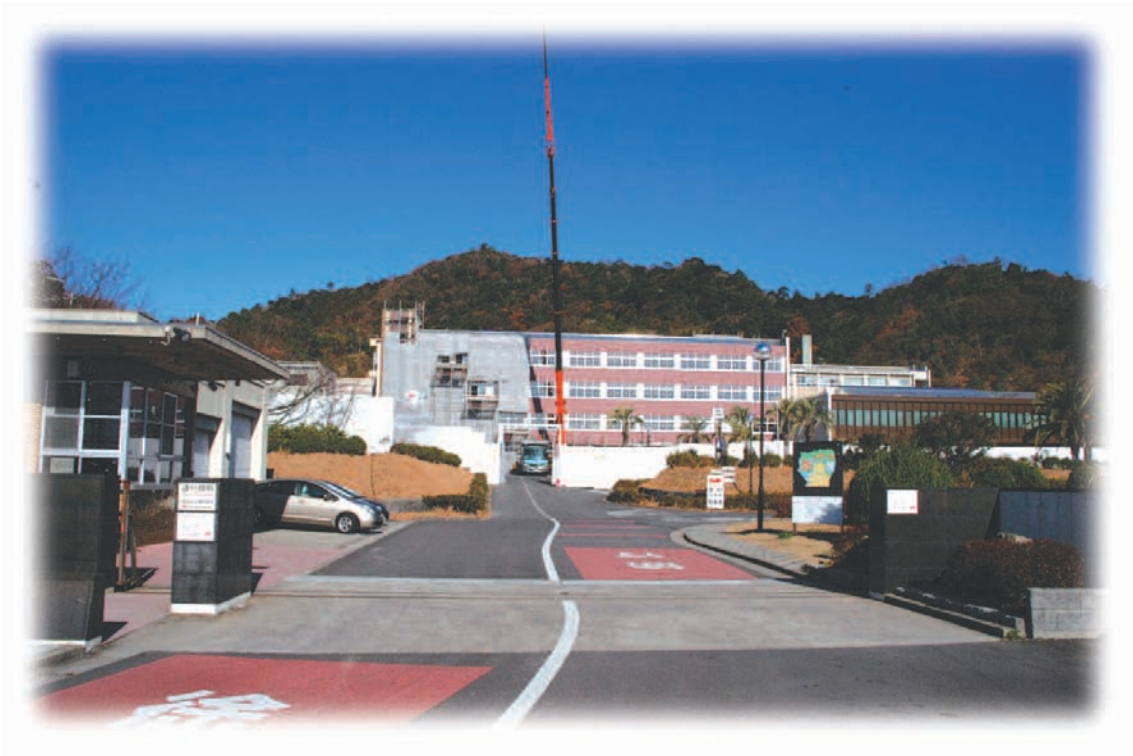
校舎改修中の様子(平成20年1月撮影)
