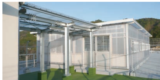
▲屋上物干場への通路も屋根設置（2010年）
