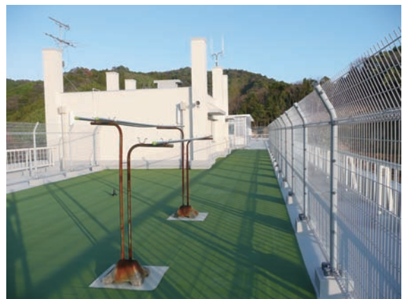
▲漏水対策ならびに防護策が施された屋上（2010年）
