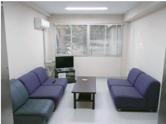
▲各室にエアコン設置（2009年）
