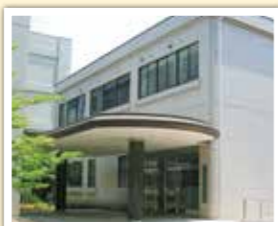
7 テクノ・リフレッシュ教育センター 現在全面改修工事中 令和3年2月完成予定
