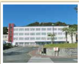
8 教室・管理棟 平成20年3月全面改修 令和元年10月外壁改修
