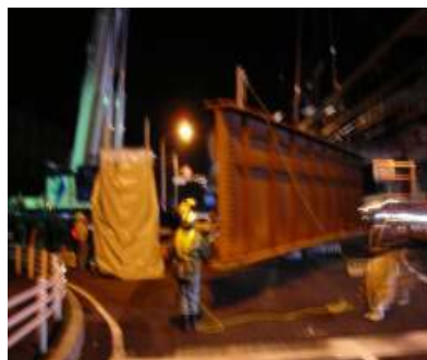
トルシアボルト 桁の一括架設
