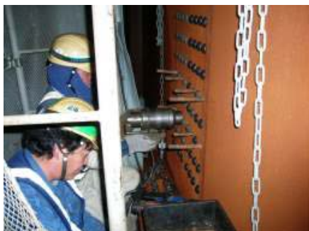
(油圧ピンと油圧レンチ (騒音防止) 夜間見学)
